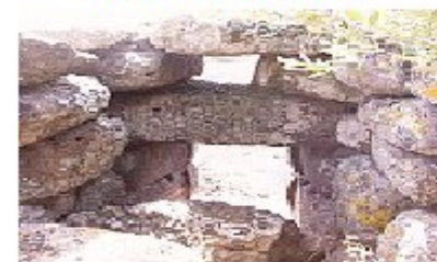
NURAGHE PONTE INTERNO
